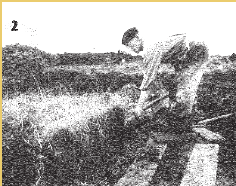
2. Het begin van het graafwerk. De bovenlaag waar je niks mee kunt wordt weggehaald.
